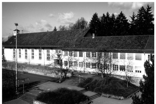
Bild 1: Photographische Ansicht der sanierten Schule in Stuttgart (vgl. [2]).
